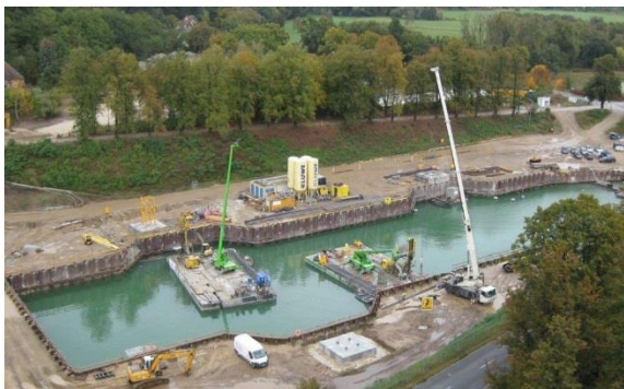
Zwei Merlo Rotos beim Beckenbau des neuen Schiffshebewerks Niederfinow-Nord
